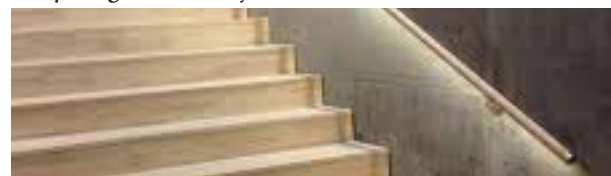
Tunnelnedgang, belysning i håndlister
