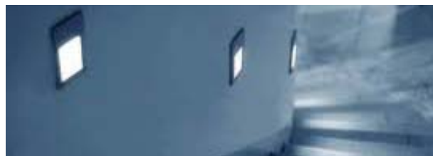
Tunnelnedgang, punktbelysning på trampe
