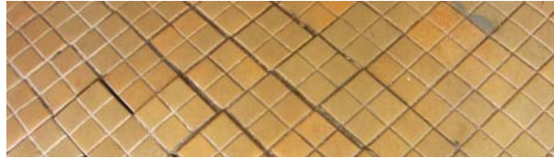
Gulvklinter afrenses og repareres
