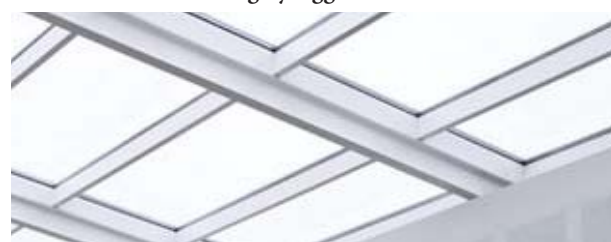
Belysning med ovenlyseffekt i tunnel
